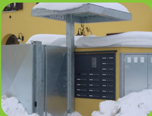
Incassato a muro
